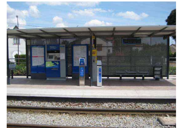
Figure 36 : Exemple de Station sur T4 - Aulnay-Bondy
