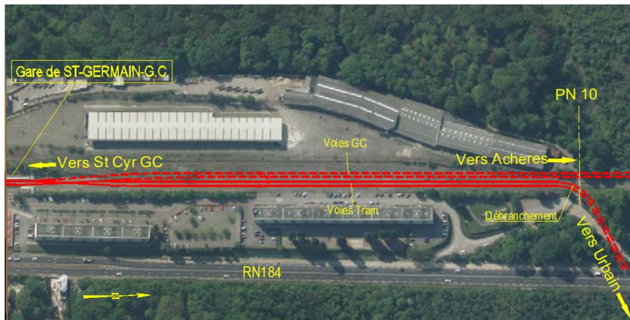
Figure 38 : Vue aérienne de la gare de St Germain (Source : SNCF Réseau – avril 2015)
